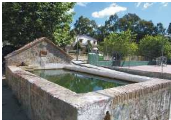
Pilar del Patio de Corchas (J.E. Sierra Velasco)
