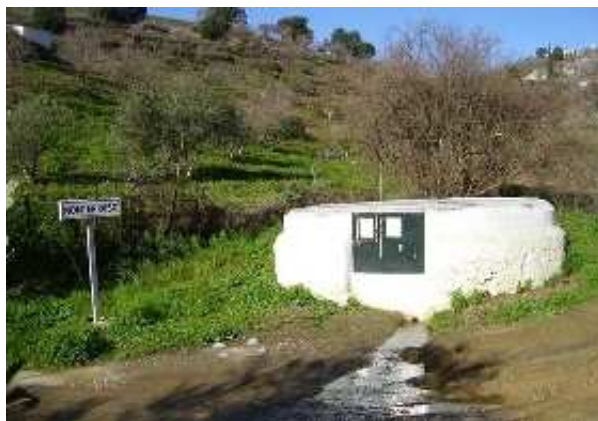
Pozo de Monterroso nuevo (J.C. Rodríguez Gómez, abril 2010)
