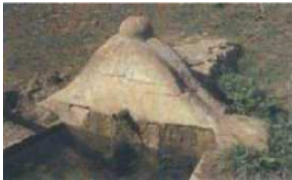
Pilar de Piedra Hincá (R. Córdoba)
