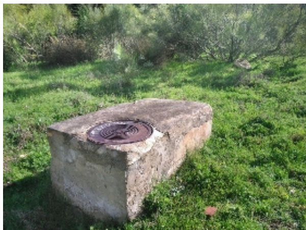
Manantial de Las Vegas, caseta de captación (M. García, mayo 2021)
