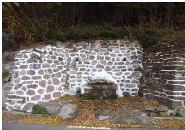
Fuente de Fallarique (V. M. Robles Arenas, diciembre 2014)
