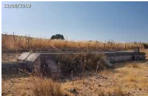
Pilar principal, mostrando los contrafuertes (A. Ventas. agosto 2019)
