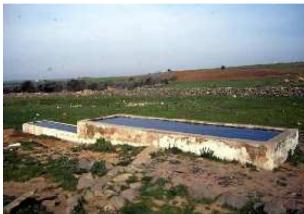
Pilar de la Coronada (R. Córdoba, 1998)
