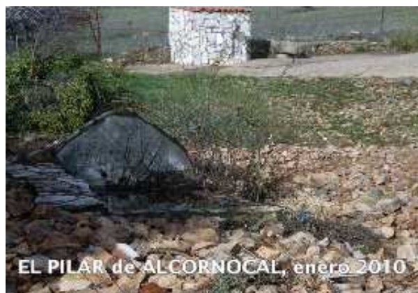
Pilar del Alcornocal, después de lluvias torrenciales (Omar, 2010)
