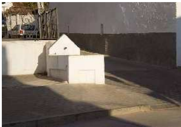
Pilar de Santa Ana (Sevillapedia, enero 2010)
