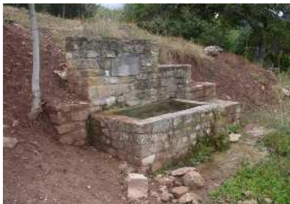
Fuente de Prados Bajos (J. D. Cano Cavanillas, septiembre 2008)
