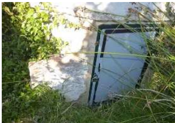
Fuente El Cabañil, caseta de protección (J. L. Acebes, noviembre 2013)
