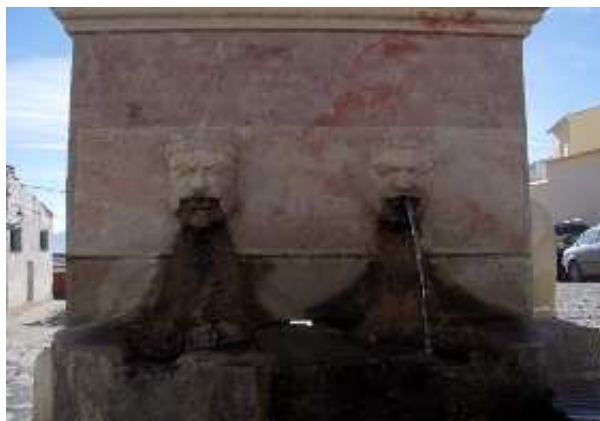
Pilar abrevadero de la Fuensanta (S. Rodríguez, enero 2010)
