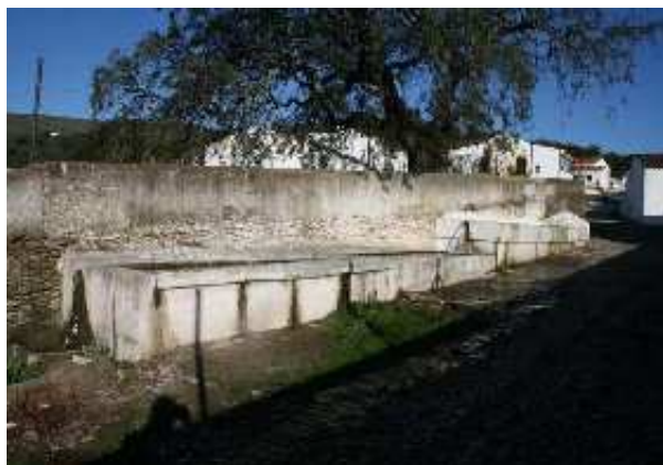
Fuente de la Caña, vista general (J.L. Macias Rico, enero 2010)
