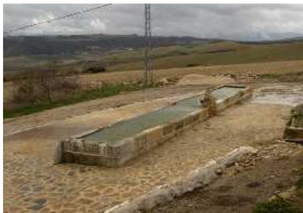
Pilar - abrevadero de Ronda la Vieja (S. Rodríguez Domínguez, enero 2010)
