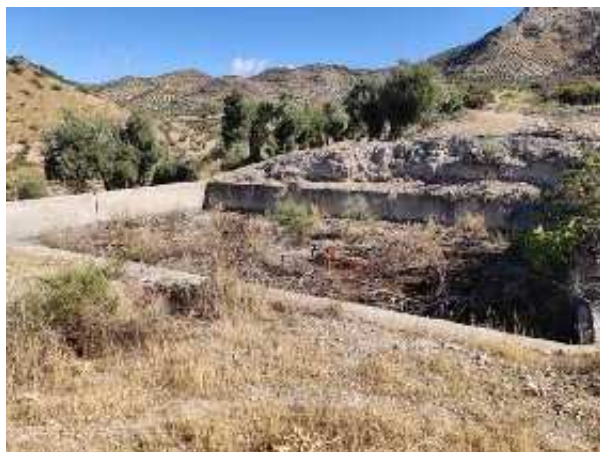
Vista general de la alberca de Zarzalejo (D. Sánchez Garrido, octubre 2020)
