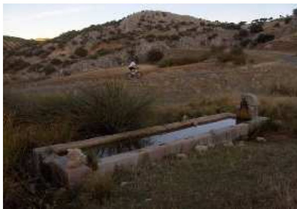
Pilar abrevadero de Calle (S. Rodríguez Domínguez, octubre 2009)
