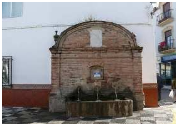
El Pilar de Zafarraya (J. A. Miranda, enero 2010)
