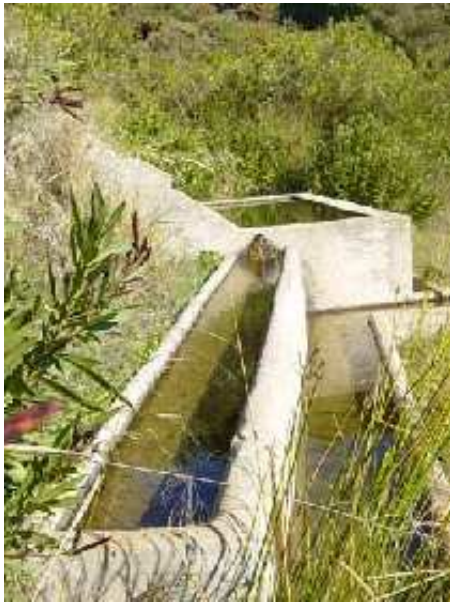
Fuente Janón, vista general, con detalle del pilar y depósito (A.J. Peña Toro, diciembre 2007)
