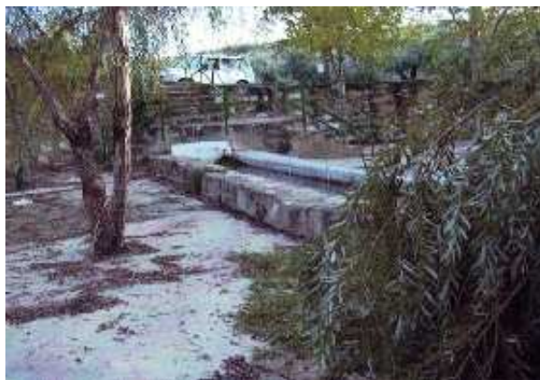
Pilar de la Dehesa, abrevadero (J. Alba Martínez, noviembre 2009)
