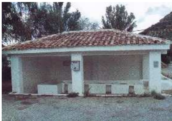
Fuente de Puertollano y lavadero (A. Vidal Monzó, octubre 2009)
