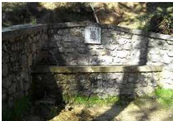
Fuente de la Canalica (A. Guzmán Rodríguez, octubre 2009)
