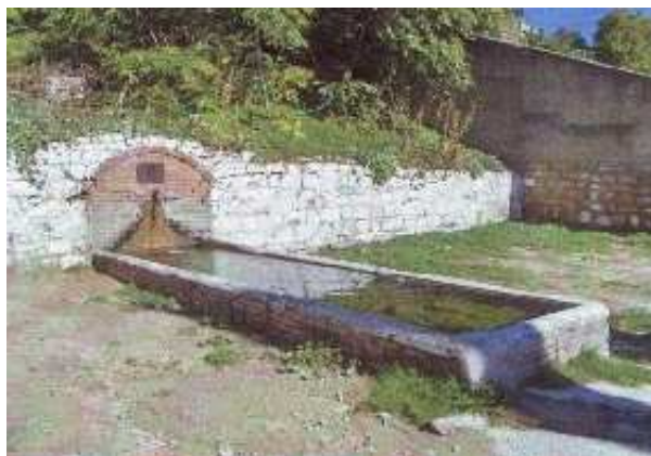
Fuente el Pilarejo, vista general (J. F. Ferrer Montiel, octubre 2009)
