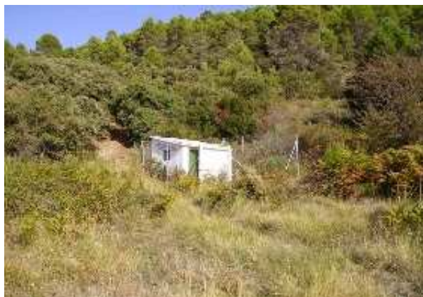
Caseta de captación de la Hoyuela (M.A. Robles Castillo, septiembre 2009)
