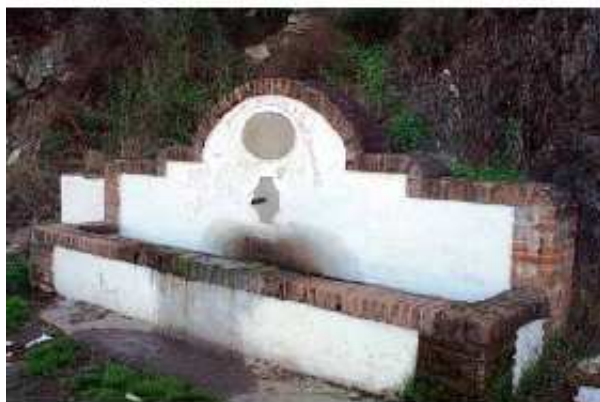
Pilar del Agua Buena (J. L. Macías, noviembre 2009)
