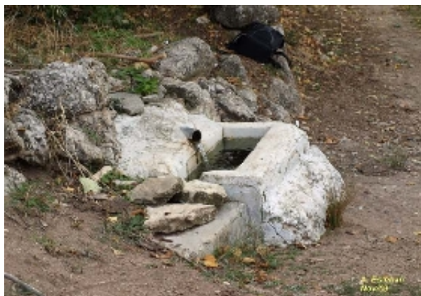
Fuente del Cañuelo (A. Esteban, noviembre 2009)
