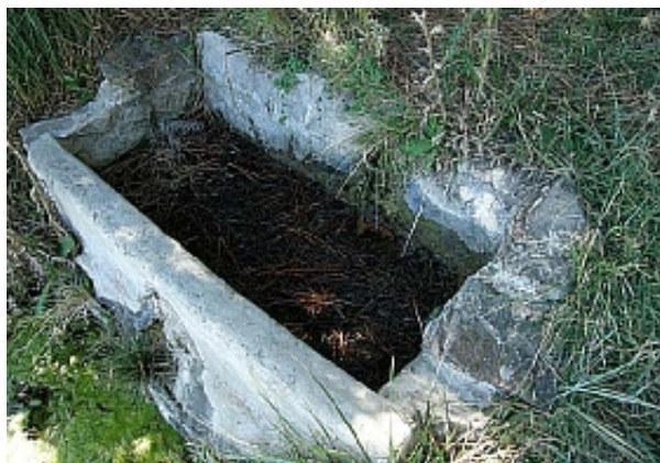
Fuente del Cerro El Fuerte (A. Vela Torres, octubre 2009)
