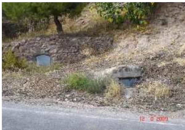
Fuente de los Álamos. Galería y aljibe (J.Martín Jiménez, octubre 2009)
