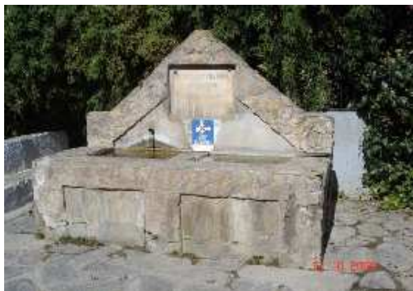
Fuente del Puente (J.Martín Jiménez, octubre 2009)
