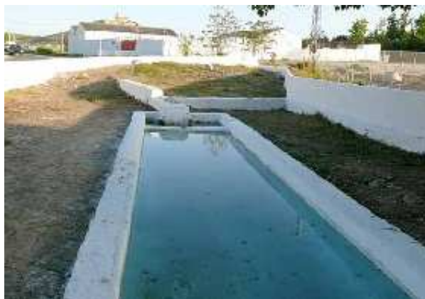
Fuente Granada con agua, remodelada (R. Martín Sánchez, abril 2011)
