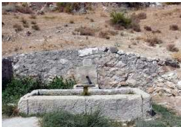
Pilarillo de los Terreros (R. Martín Sánchez, septiembre 2009)
