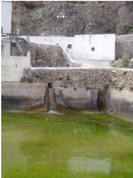
Manantial de la Zanja (J. Gisbert, marzo 2005),
