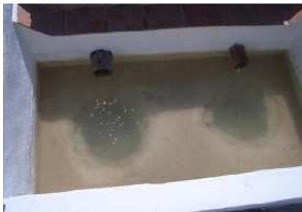
Detalle de la decantación del agua
