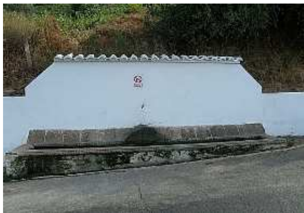
Fuente El Pilar o pilarillo de Arriba (A. Vela Torres, agosto 2009)
