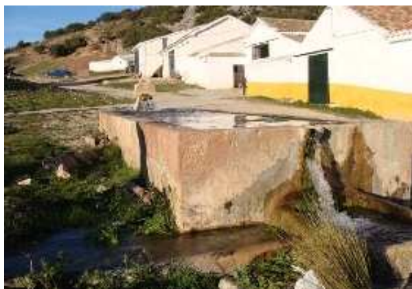
Vista general del Pilar y la cortijada (L. Linares, diciembre 2008)
