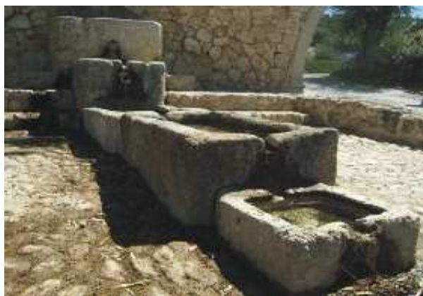
Fuente del Convento de la Magdalena, vista de las piletas inferiores (F. Cuesta López, agosto 2009)
