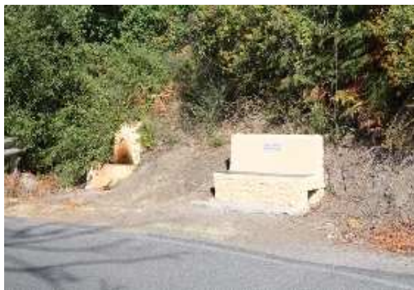
Fuente Agua Agria de Mecina (Ayuntamiento de la Tahá, agosto 2009)
