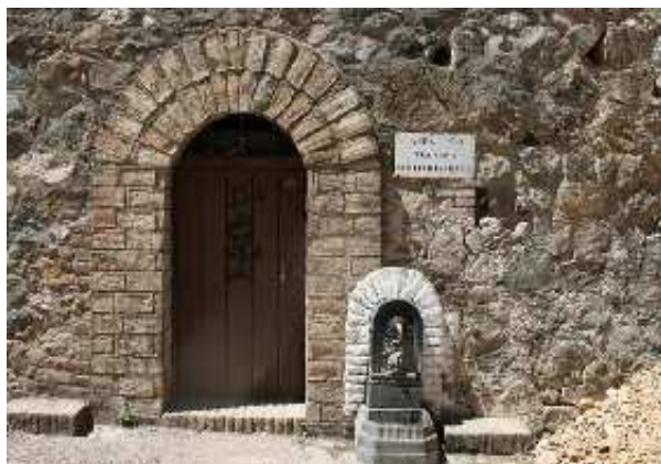
Fuente del Callejón, entrada a la galería y fuente (J. L. Macías Rico, julio 2009)
