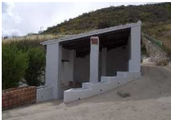
Fuente-Lavadero Municipal de Atajate (S. Rodríguez, junio 2009)
