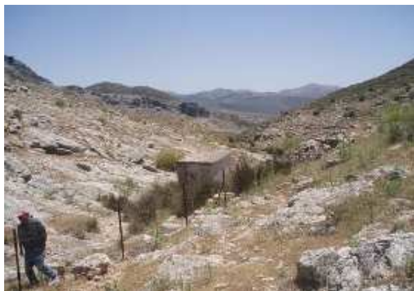
Manantial de Nazana. caseta de captación (M.T. Jiménez, junio 2009)
