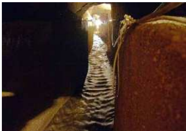
Interior de la Galería de Maiscenteno (A. Castillo, mayo 2009)
