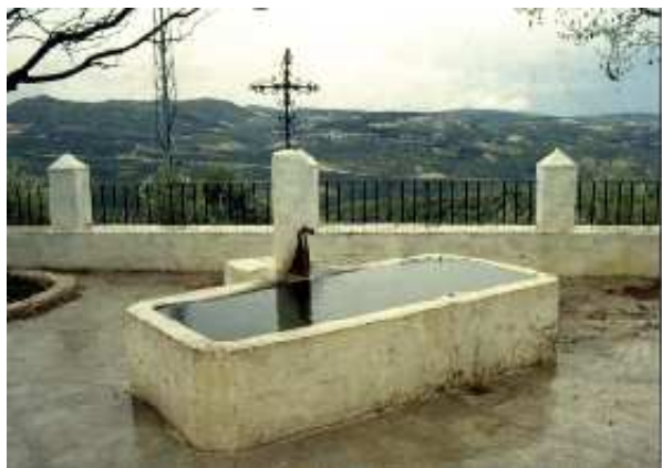
Fuente del Mirador de la Villa (R. Córdoba, 1998)
