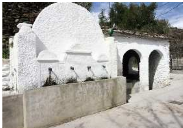
Fuente de la Plaza (A. Bañuelos Arroyo, enero 2007)
