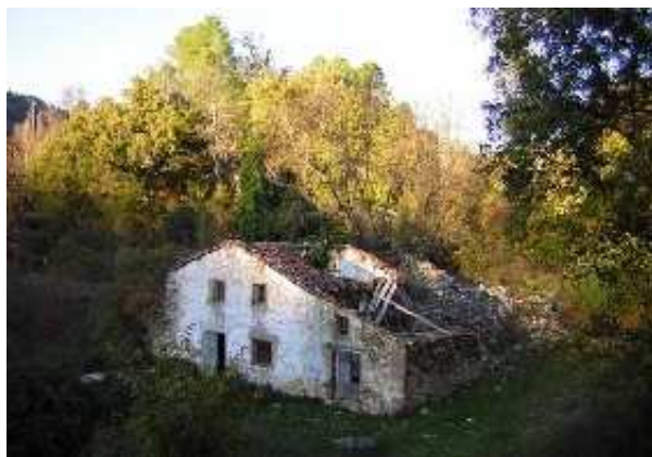
Ruinas del Molino de Barreras (Fundación Gypaetus, diciembre 2008)
