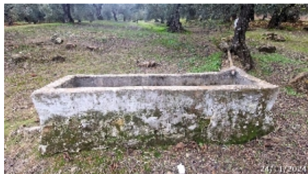
Pila vista lateralmente, terreno abajo (A. Ventas, noviembre 2024)
