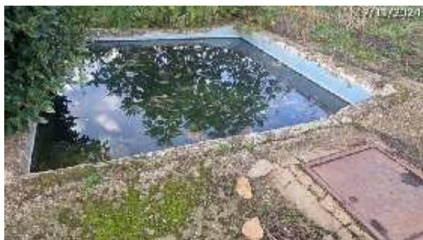
Arqueta de registro y alberquilla de la fuente (A. Ventas, noviembre 2024)
