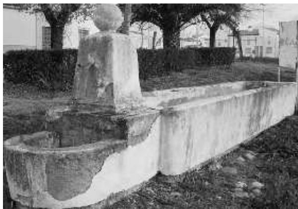
Fuente y abrevadero de la Ropera (J.A. Palomino)
