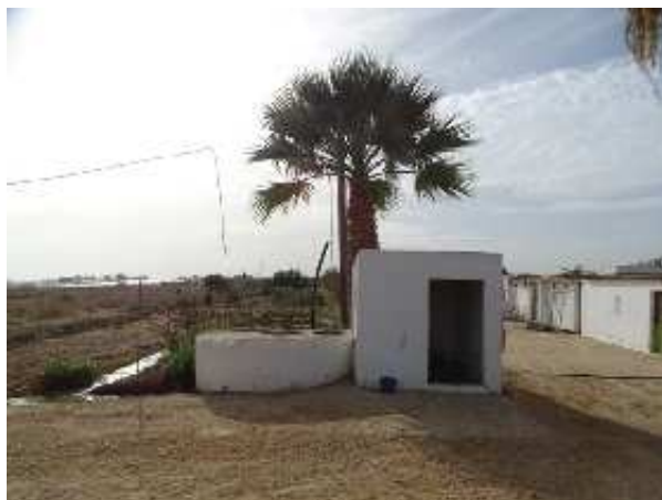
Vista del pozo (J. F. Martín Álvarez, octubre 2024)
