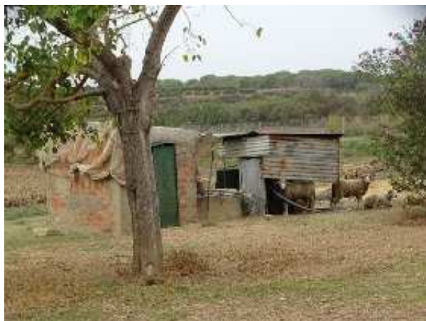
Vista del pozo y la caseta de bombeo (J. F. Martín Álvarez, octubre 2024)
