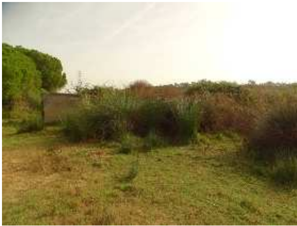
Vista de la caseta de bombeo y pozo oculto entre las zarzas, los juncos y las eneas (J. F. Martín Álvarez, OCTUBRE 2024)
