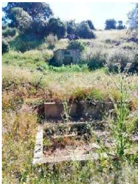
Pilar de la fuente, seco, con la alcubilla de captación al fondo (J. Javier Navas, mayo 2021)
